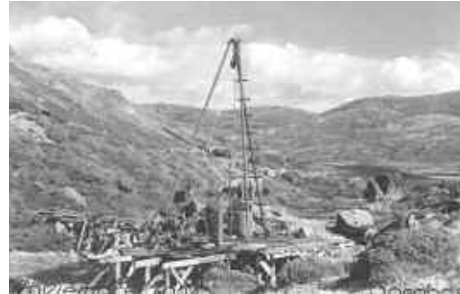
Sondeos previos a la construcción de la presa de Vega de Tera. Noviembre de 1954
