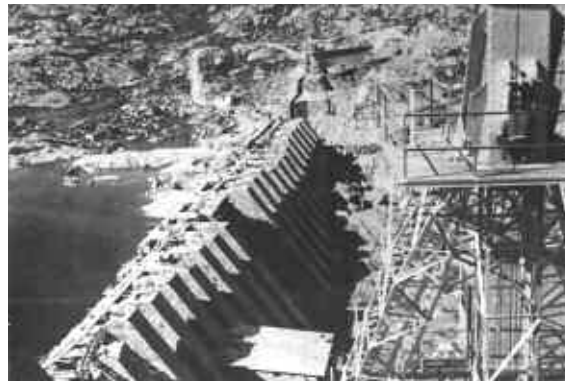
Contrafuertes, obras de construcción y excavación de cimientos de la presa de Vega de Tera. 1946 - 1956
