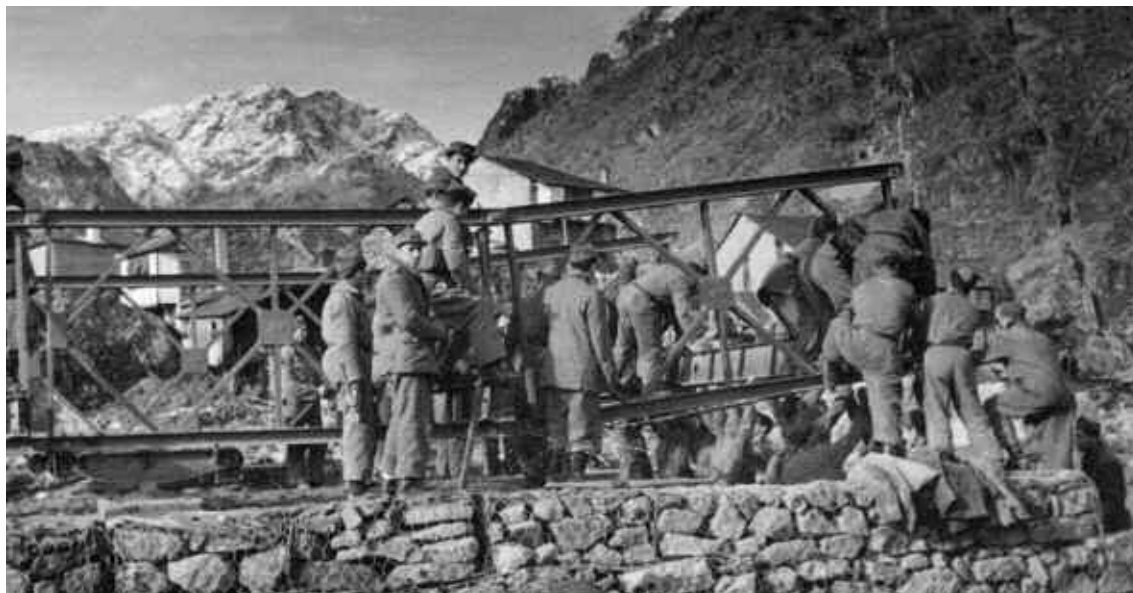
Zapadores del ejército instalando un puente metálico Bailey en Ribadelago
