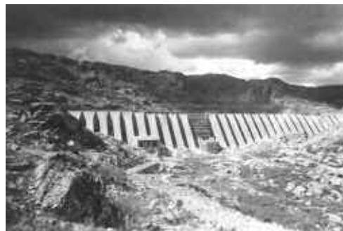
Obras de construcción de la presa de Vega de Tera. Década de 1950
