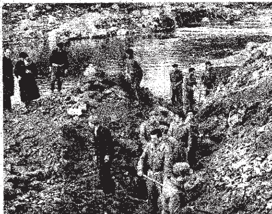
Soldados de Infantería removieron los escombros antes de que las máquinas pudieran pasar el epicentro de la catástrofe.
