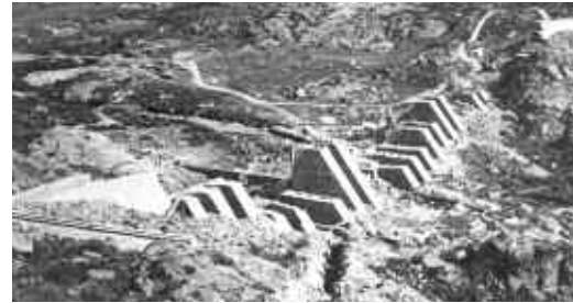
Obras de construcción de la presa de Vega de Tera. Década de 1950
