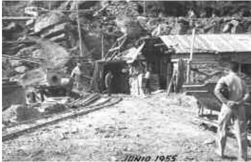
Obras de construcción de la presa de Vega de Tera. Junio de 1955
