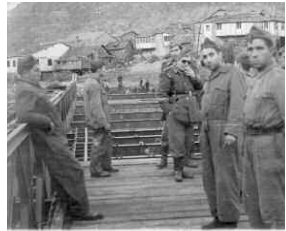
Oficiales y soldados del ejército instalando un puente metálico Bailey provisional en Ribadelago, tras el desastre de Vega de Tera en 1959
