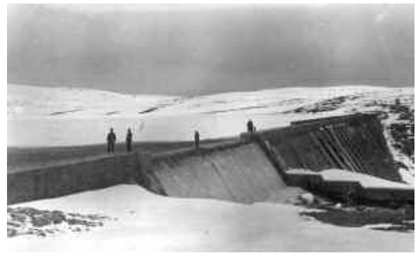
Inicio de la construcción y remate final del aliviadero de la presa de Vega de Tera. Década de 1950
