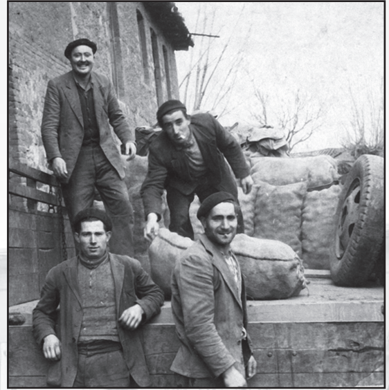
Transportando patatas, un producto habitual en los camiones que circulaban sobre el puente de hierro.
