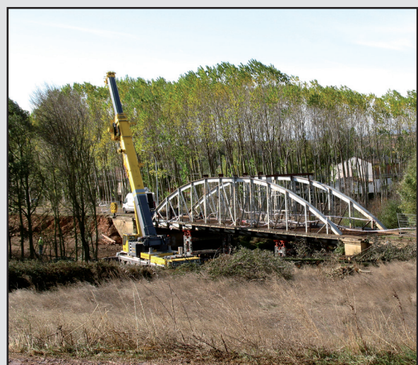
Momento de desmonte del puente de hierro
