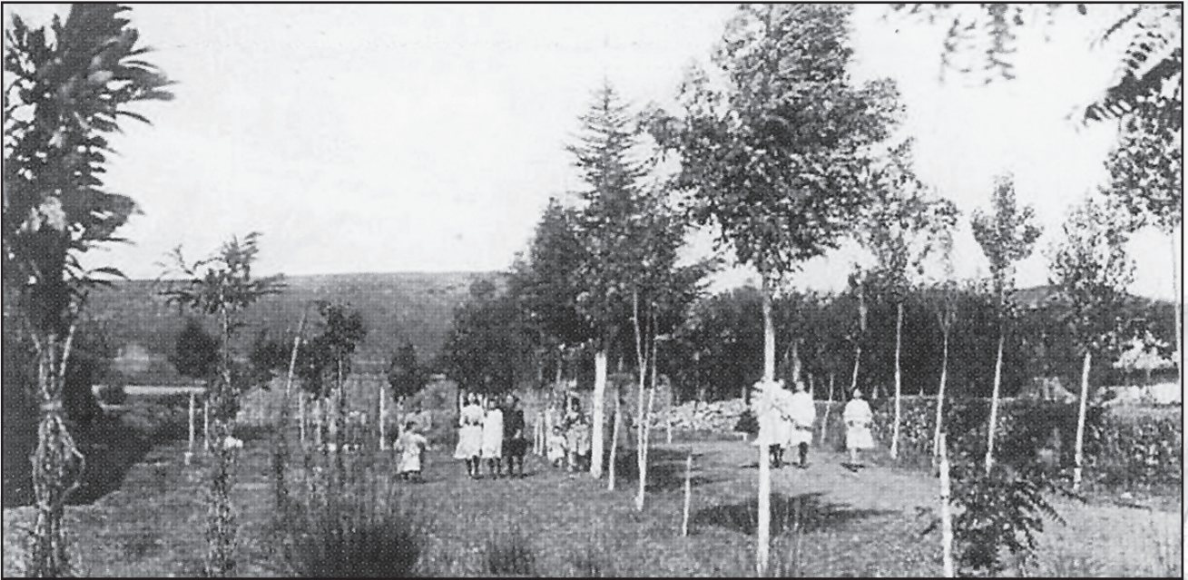
Disfrutando el ocio, a la vera de la Forti, en los días en que se construía el puente. Imagen cortesía de Fernando Alonso García
