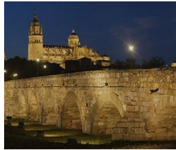
Mirador del Puente Romano
